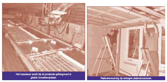
Plofverwarming bij vertoogde plofconstructie.
