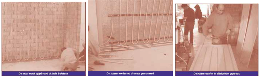
De muur wordt opgebevoerd uit holle bakstenen.
